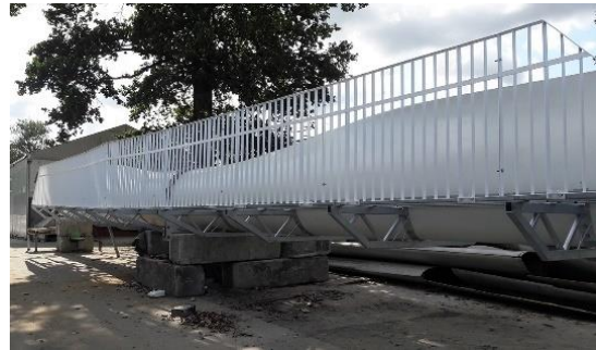
Fig. 5 – Brug in bouwfase
